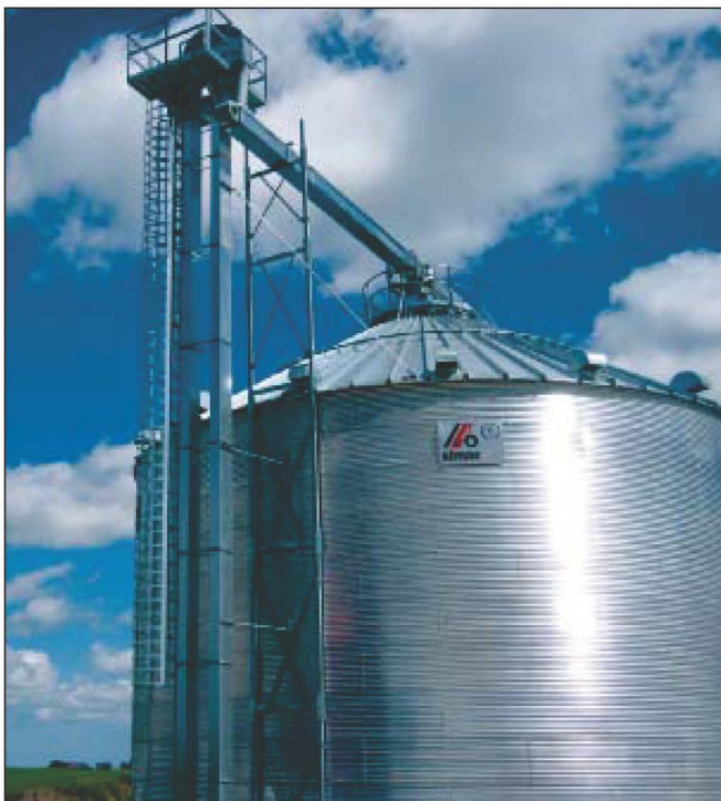
Den korrekte fyldning af en amerikanersilo kræver, at kornet lander korrekt ned på kornfordeleren. Det er lettest at styre med et anlæg som dette.
